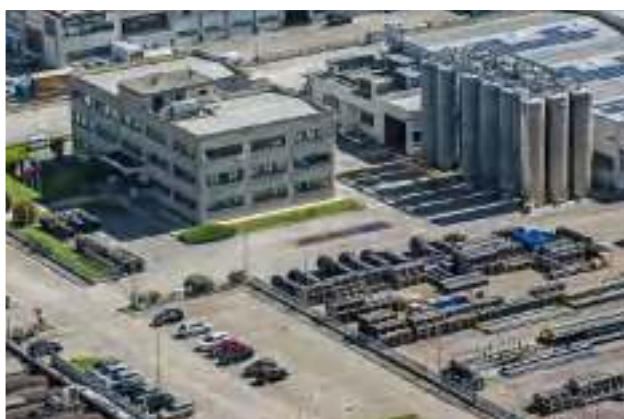
Centro Operativo - Castel Guelfo di Bologna (BO)
